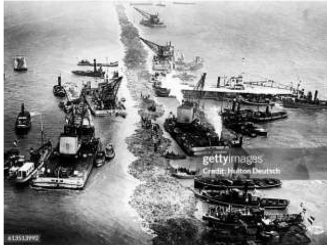
Gambar 1.2. Contoh awal teknik reklamasi besar-besaran menggunakan tanggul dan pompa air.
